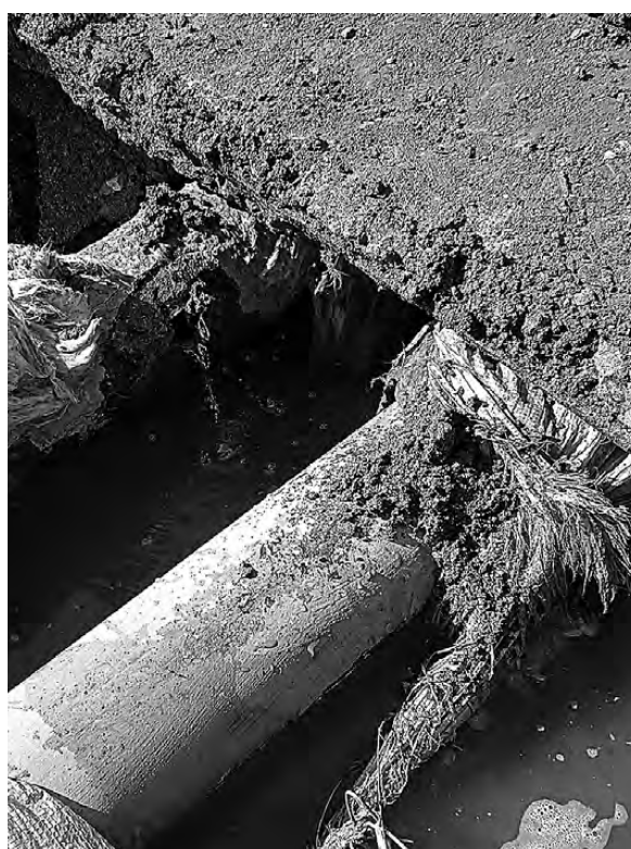
Ликвидация аварии у дома №104 на Ленинградском проспекте. Вот так выглядят трубы, которые прослужили много лет.
