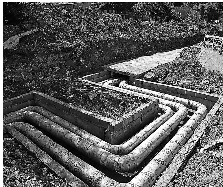
Канал теплотрассы с замененной трубой.
