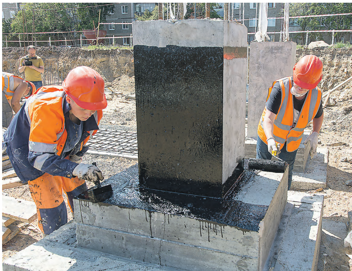
Началось строительство культурно-образовательного центра.
