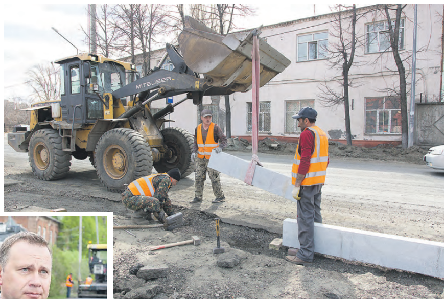
Установка бордюров на Черноисточинском шоссе.
