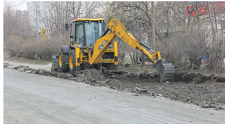
Земляные работы на парковке.
