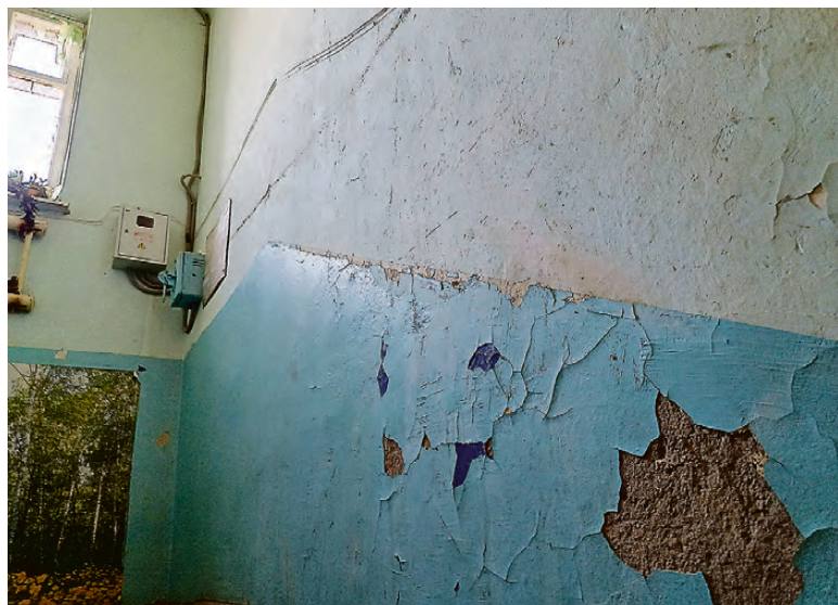
Внутренняя «отделка» подъезда
