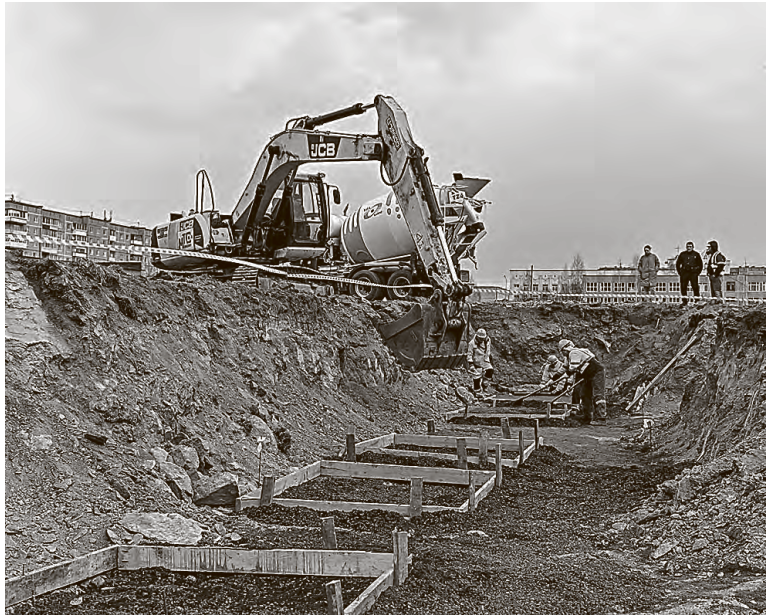
На объекте используют стаканые фундаменты.
