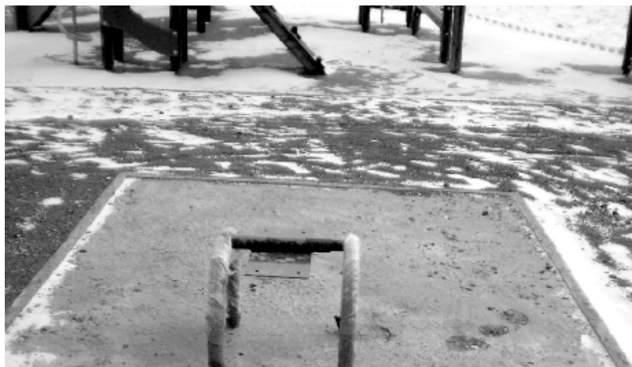
Недостроенная площадка ушла под снег.
