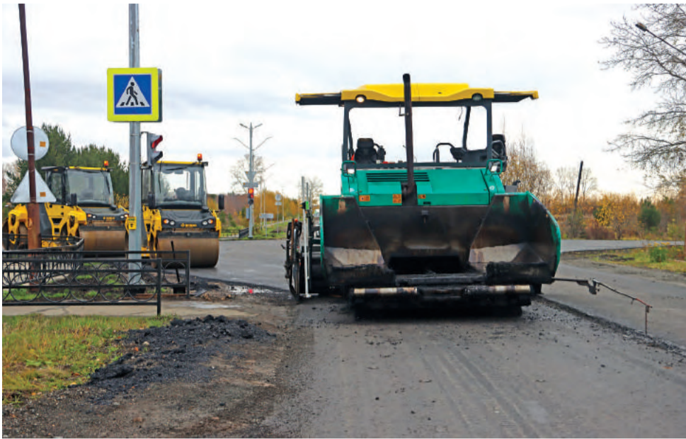
Техника ждёт поставки асфальта, чтобы продолжить укладку финального слоя дорожного полотна по Объездной.
