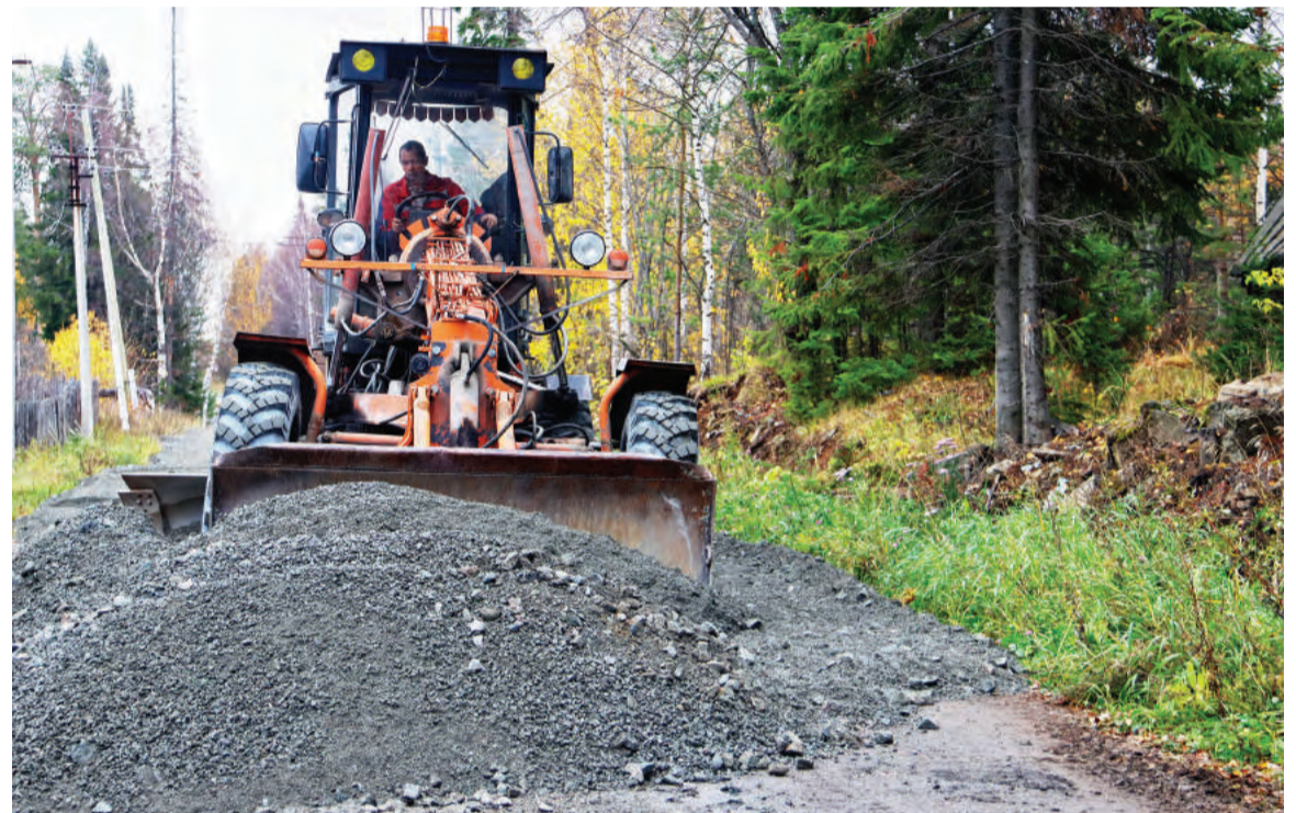
Отсыпка щебнем основания новой дороги по улице Куйбышева.
