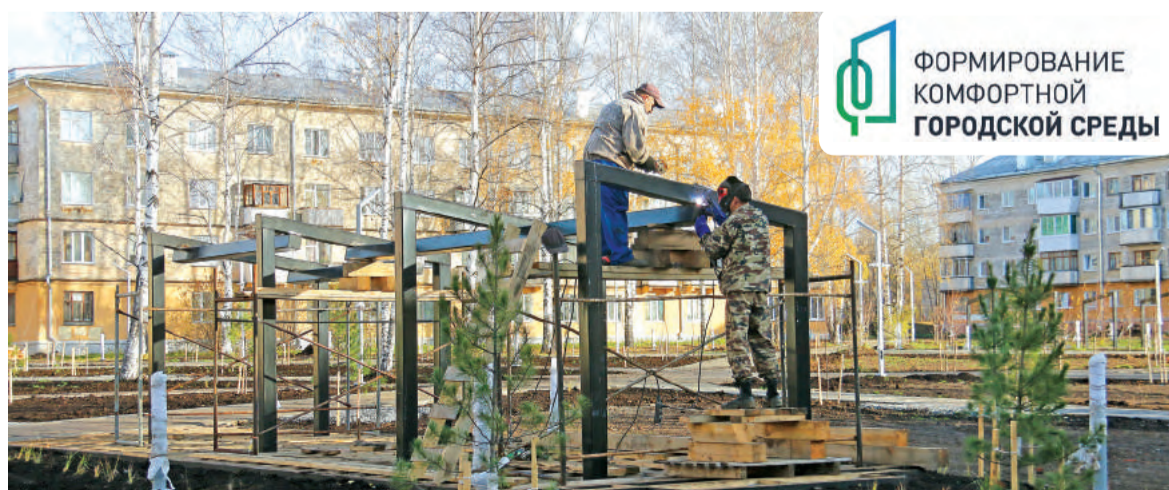
Монтаж каркаса качелей в сквере.
