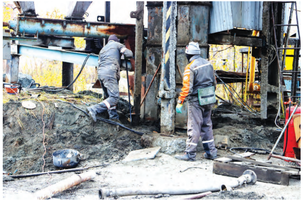
Демонтаж старой асфальтовой установки на производственной базе УГХ.
