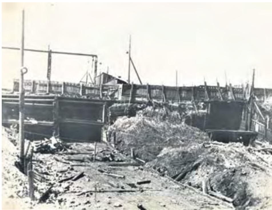
Разборка старой плотины в 1964 году.
