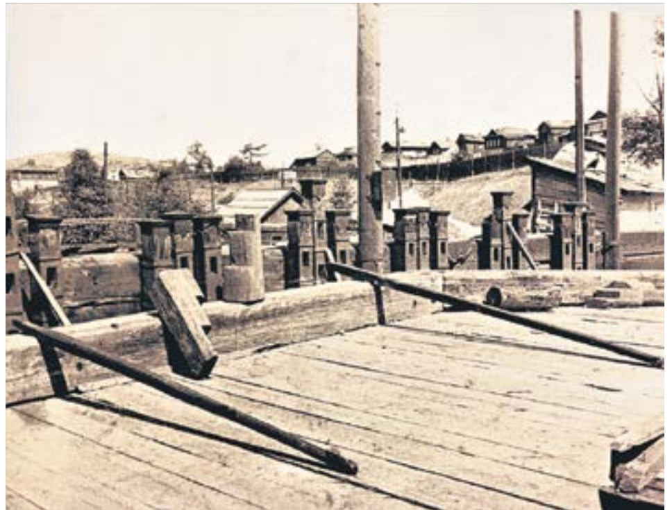
Ломы и упоры для подъема запорных щитов плотины.
