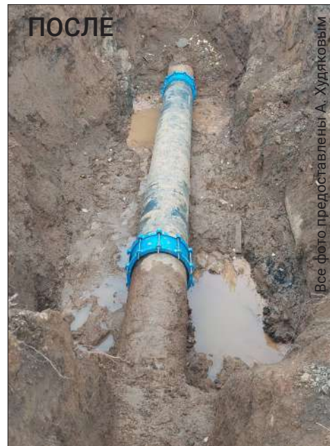
Сети холодного водоснабжения южной части проходили в этом году гидравлические испытания на протяжении нескольких месяцев. Аварий было много, не выдержал и магистральный водовод диаметром 500 мм (на фото, ул. Магистраль). Утечку на нём устранили, заменив шесть метров стальной трубы на полиэтиленовую
