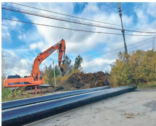
максимум: дотянуть две нитки новых полиэтиленовых труб до врезки в одну из камер в районе производственного корпуса 22. Для производства работ пришлось даже ненадолго перекрыть проезжую часть в направлении цехов № 54 и № 55.
