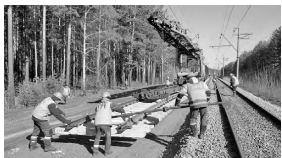
На полигоне СвЖД в этом году капитально отремонтировали 319 километров пути.
