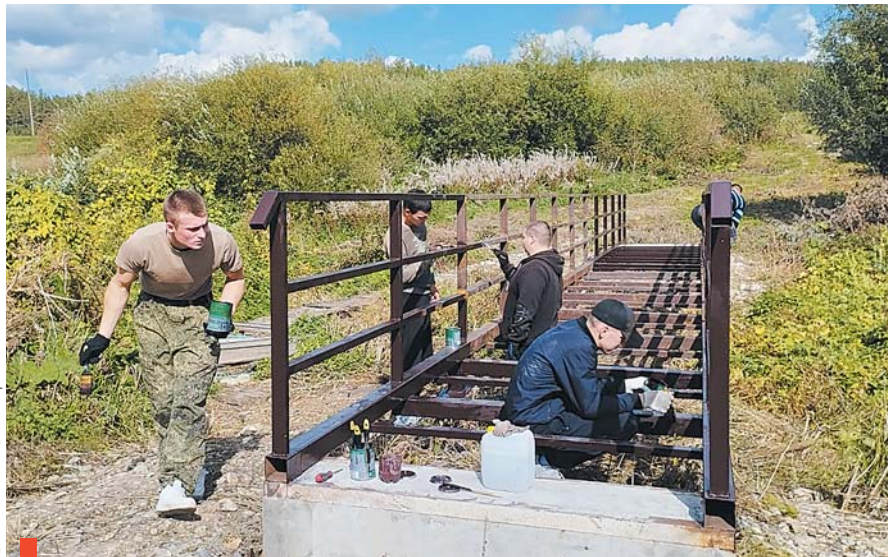
Покрывание металлических конструкций защитной краской
