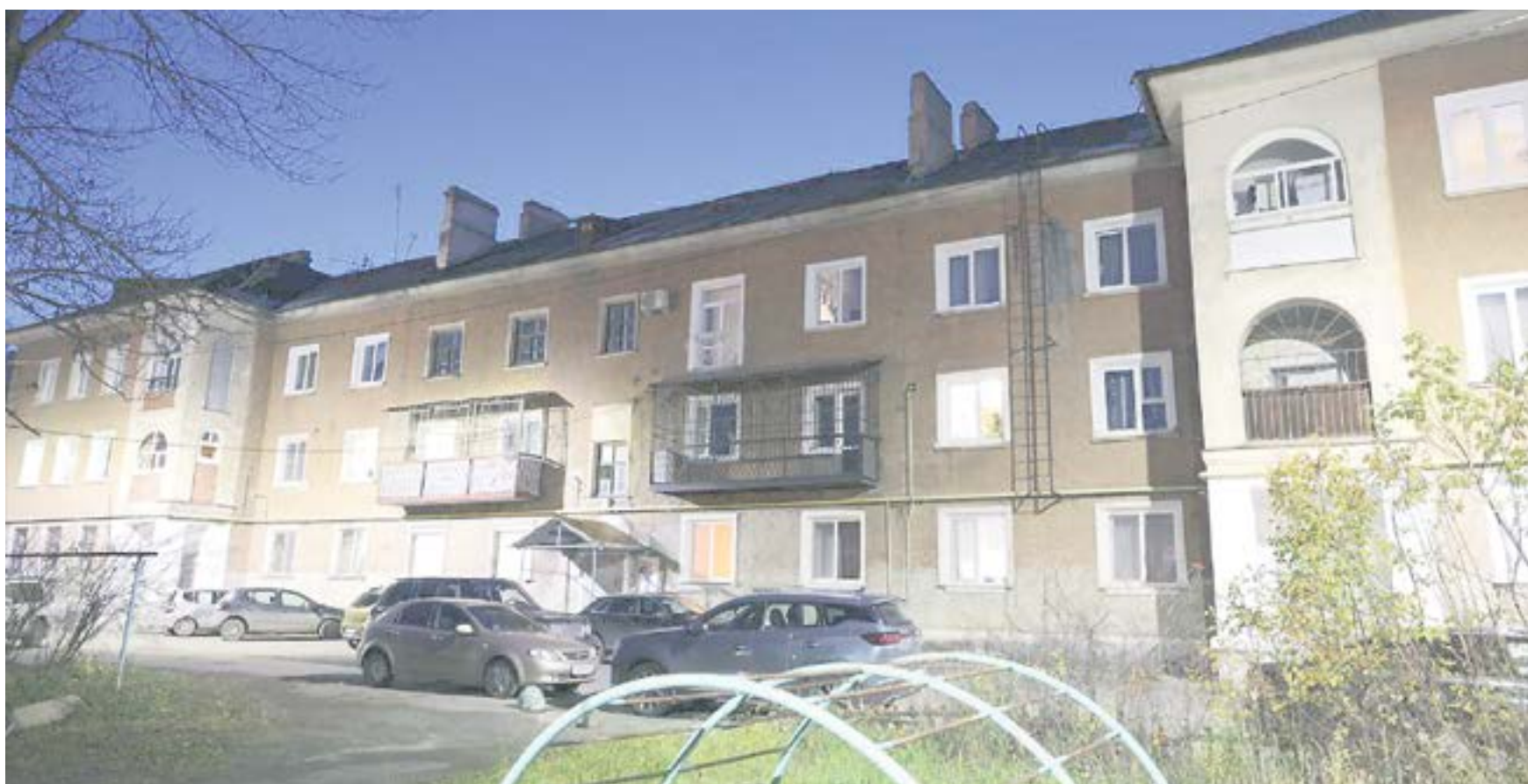
Жуковского, 23 стал единственным домом Ревды, которому в 2024 году полноценно отремонтируют крышу. Остальным семи участникам программы так не повезло. // Фото Владимира Коцюбы-Белых
