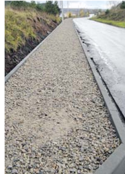
Строится тротуар в деревне Алапахе
