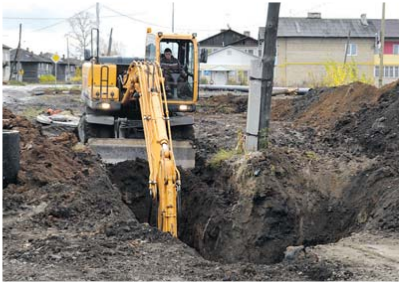
Идёт строительство сетей водоотведения в Октябрьском
