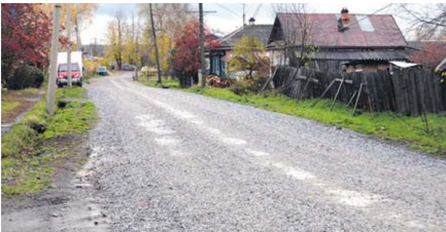
Дорога на ул. Глухих
