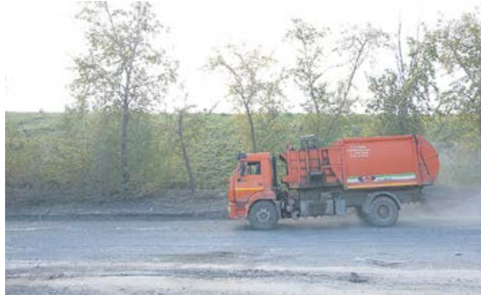
Реконструкция старой дороги на Первоуральск станет первым проектом, который будет воплощен в жизнь в рамках агломерации. // Фото Владимира Коцюбы-Белых
