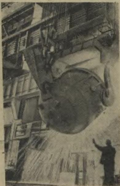
Липецк. Коллектив кислородно-конверторного цеха-исполнитель, только вступивший в эксплуатацию на Ново-Липецком металлургическом заводе, настойчиво осваивает новейшее оборудование и уже дает сталь. Большегрузные конверторы через каждые 50 минут выдают плавки. Их тут же принимают установки непрерывной разливки стали, в которых расплавленный металл в считанные минуты превращается в готовые к прокатке слэбы. Такой конвейер создан впервые в практике мировой металлургии.
