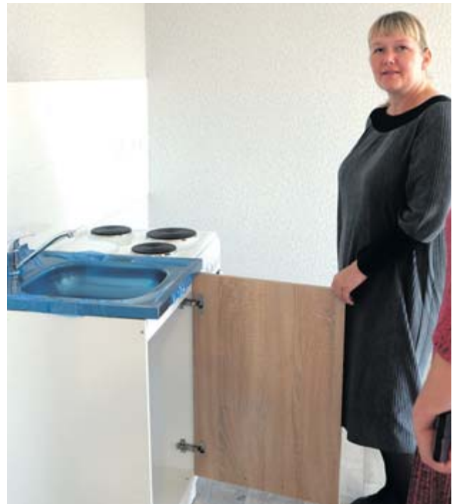
Кухня оснащена мойкой и плитой. Елена Лихарева проверяет выполнение работ
