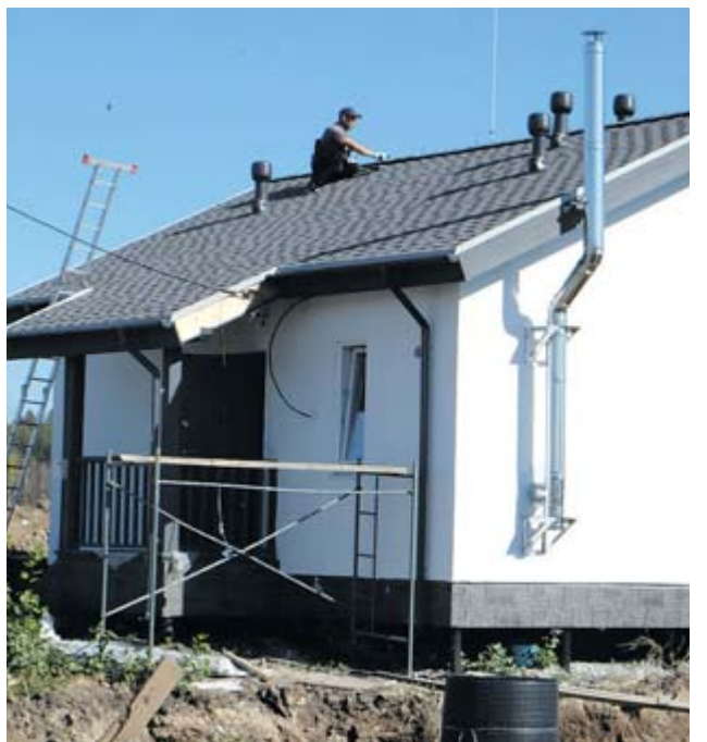
Рабочий устанавливает на крыше громоотвод. На каждом доме по четыре трубы – дымоход, вытяжки из санузла, кухни и канализационных труб. Кроме того, в спальнях сделаны вентиляционные для притока свежего воздуха
