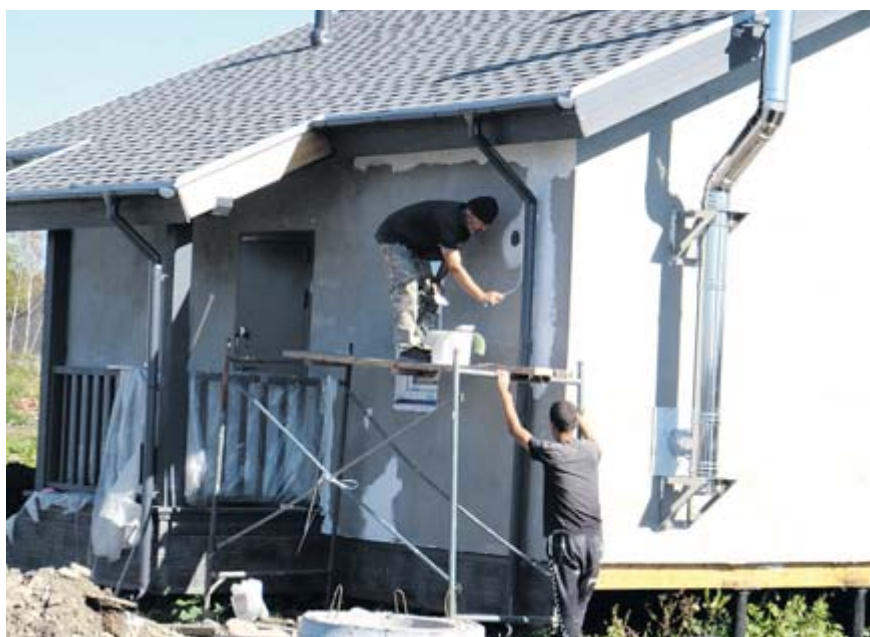
Идёт отделка фасада
