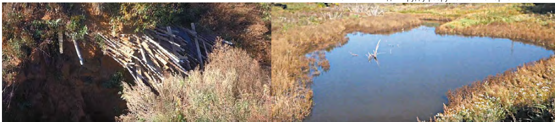
▼ Вот так выглядит пруд у разрушенной пожарной плотины
