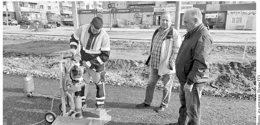
Выемка керна с отремонтированной дороги на ул. Юбилейной
