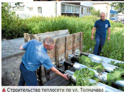
▲ Строительство теплотрассы по ул. Толмачева
