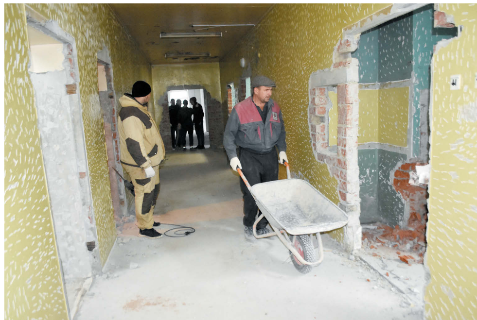
Идёт ремонт в инфекционном отделении.
