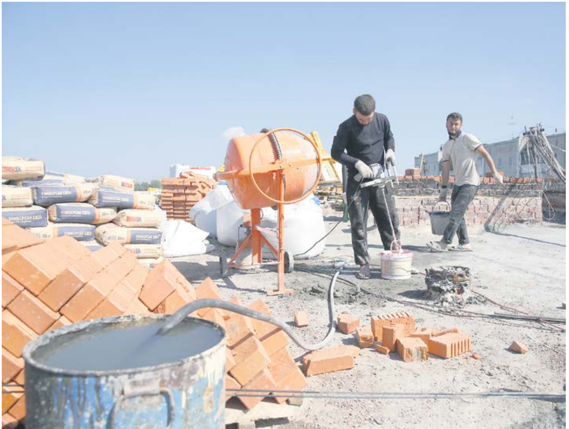
Вот так в прошлом году ремонтировали крышу дома №1 по улице Ковельской. И этот дом стал первым, где пока отремонтировали только крышу. Сейчас таких домов в Ревде гораздо больше. // Фото из архива редакции
