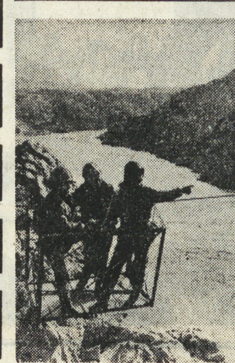
Новая станция каскада
