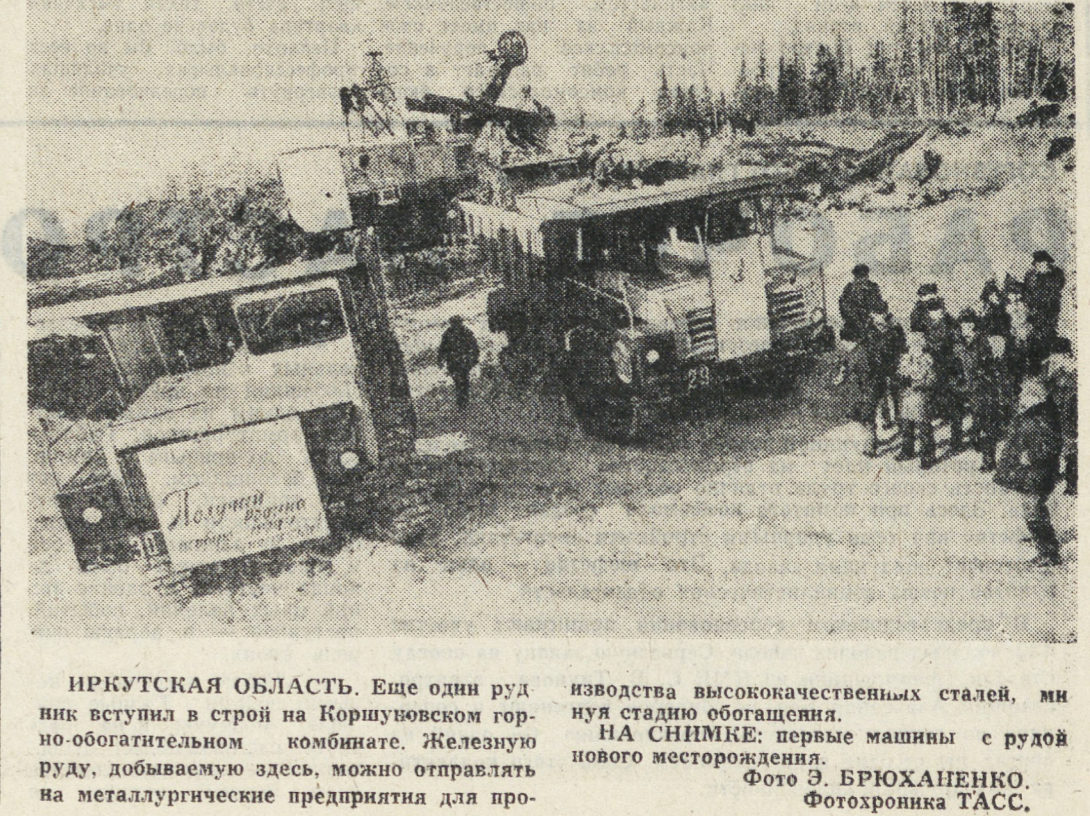
ИРКУТСКАЯ ОБЛАСТЬ. Еще один рудник вступил в строй на Коршуновском горно-обогатительном комбинате. Железную руду, добываемую здесь, можно отправлять на металлургические предприятия для производства высококачественных сталей, минуя стадию обогащения. НА СНММКЕ, первые машины с рудой нового месторождения. Фото Э. БРЮХАНЕНКО Фотолента ТАСС.
