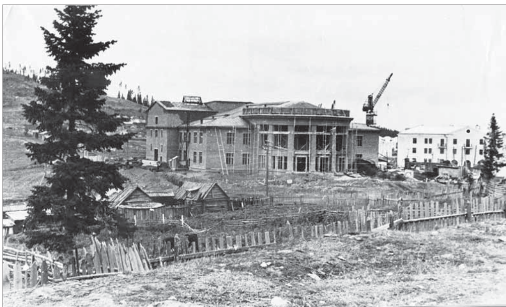
] Строительство Дома культуры. Фото сделано 8 сентября 1959 года. Через год и три месяца ДК примет своих первых гостей / ФОТО ИЗ ФОНДОВ НИЖНЕТУРИНСКОГО МУЗЕЯ
