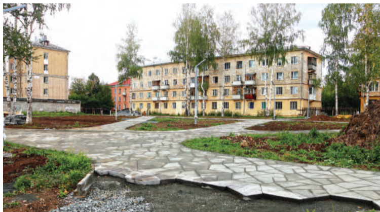
Укладка плитки в сквере за «Дружбой» завершена на 85%.
