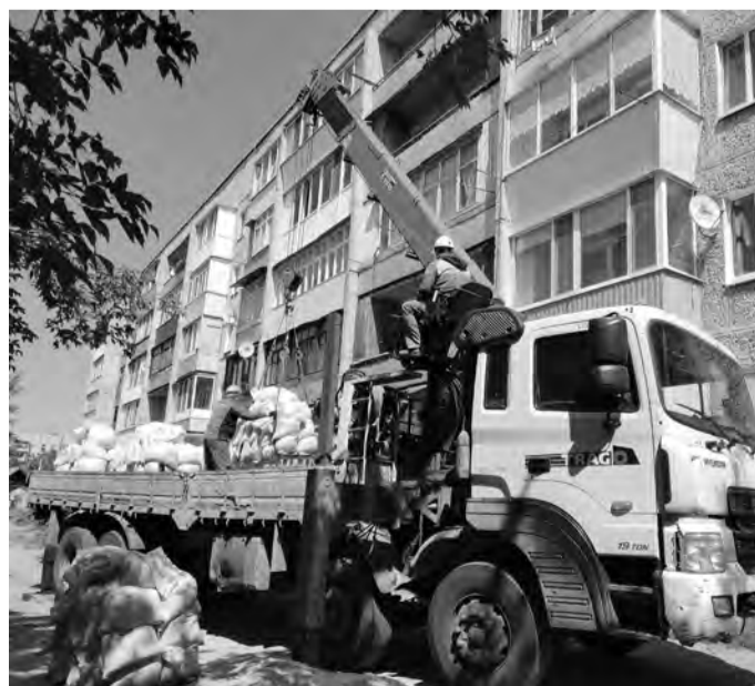
Капремонт кровли дома № 6 по ул. Рябиновой в г. Талице. Автовышка в помощь.
