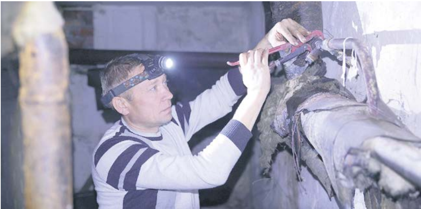
Слесарь компании «Антекс» Сергей Токарев регулирует задвижку сетей отопления в подвале дома №44 на улице Мичурина. // Фото Владимира Коцюбы-Белых
