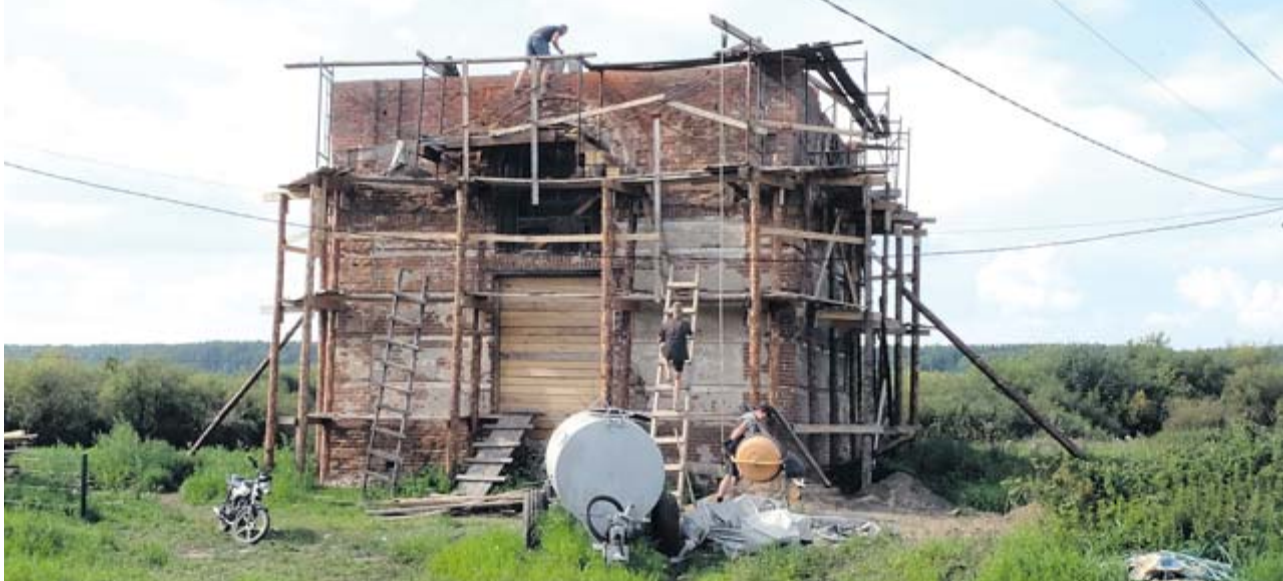
■ Полноценные восстановительные работы идут уже полтора месяца
