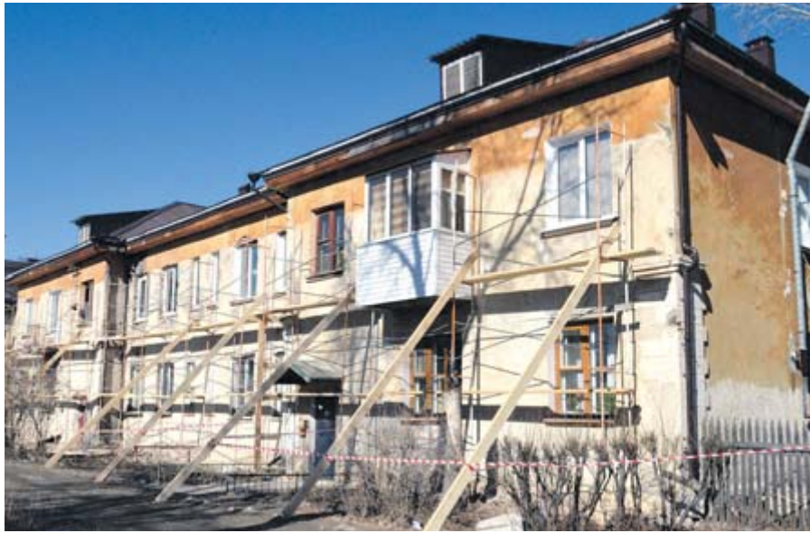
Ремонт дома на улице Фрунзе в Алапаевске
