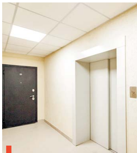
Лифтовый холл в подвале
