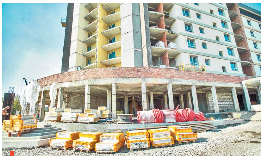
Строительство второй очереди подходит к концу
