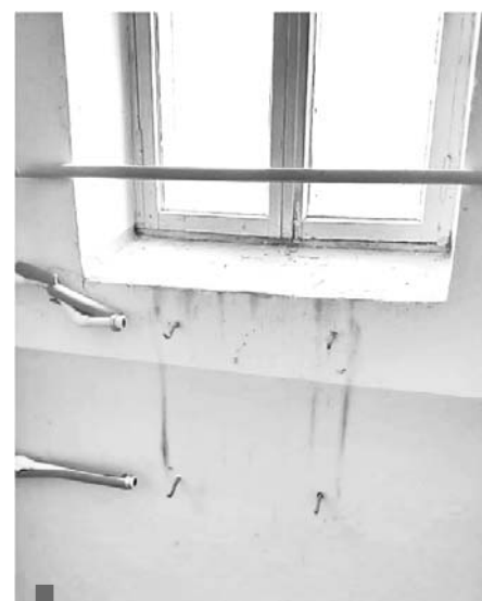
Рadiator в подвале дома на ул. Фрунзе срезали вандалы
