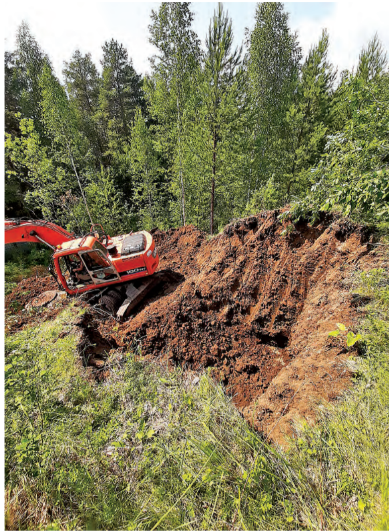
Земляные работы на горе Липовой.
