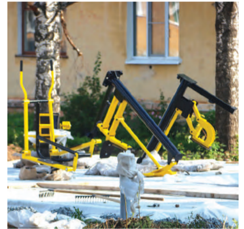
Спортивное оборудование ждёт установки.
