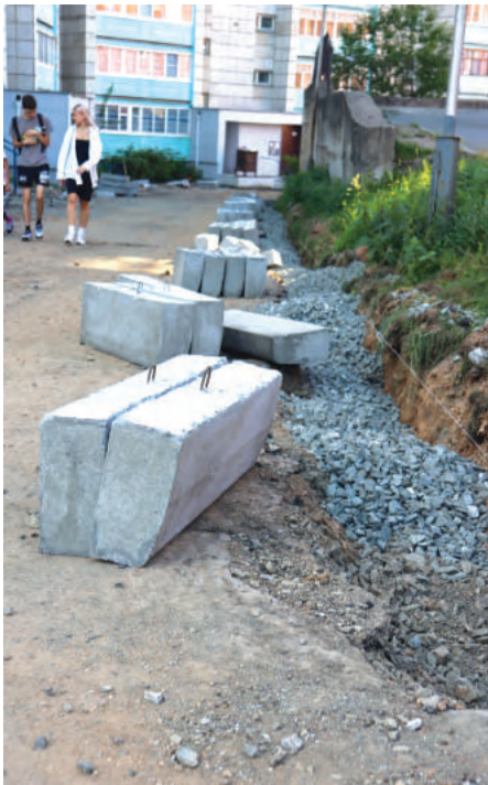
Установка бордюров. Мира, 32.
