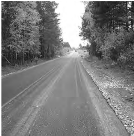
Капитальный ремонт ул. Кирова
