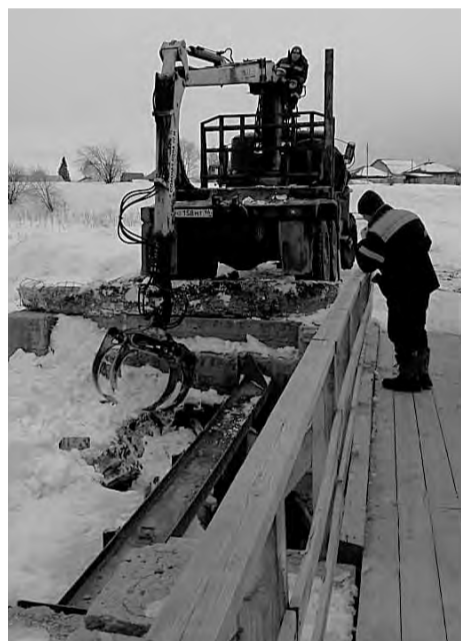
Подготовка ГТС к паводку
