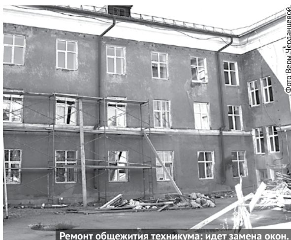
Ремонт общежития техникума: идет замена окон.
