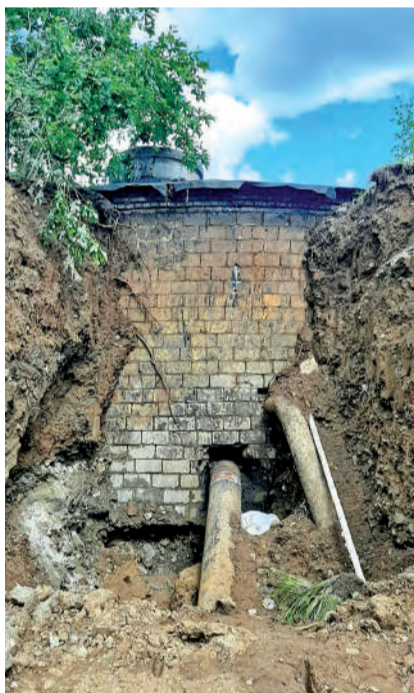
Первый резервуар чистой воды скоро будет отремонтирован.
