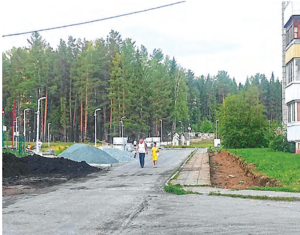
Проезжая часть вдоль Ленина, 102 – расширится. Ведётся подготовка основания для нового тротуара.
