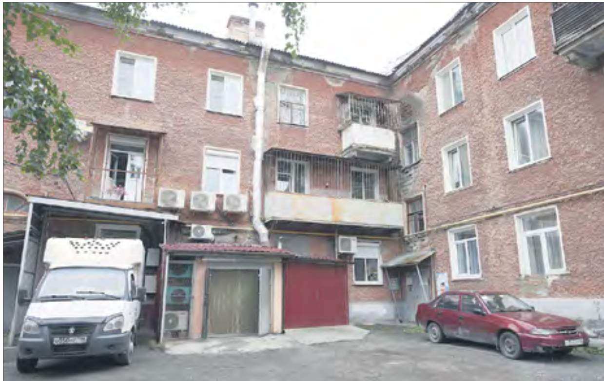
Подвал углового подъезда дома №22 по улице Чехова топит регулярно. Причин много, в том числе, изношенность сети, которая просто требует капитального ремонта. Дождется ли — пока непонятно. // Фото Владимира Коцюбы-Белых
