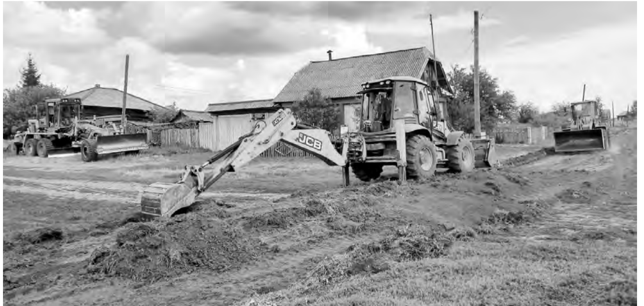
Ремонт дороги в Катараче
