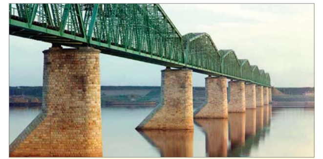
Железнодорожный мост через Каму в Перми. 1910 г.
