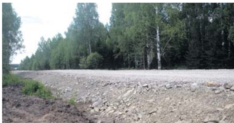
Строится дорога между Карпунинским и Таёжным
