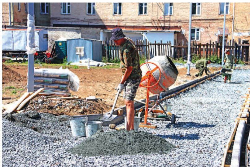
Подрядчик устанавливает бордюры новых тротуаров.
