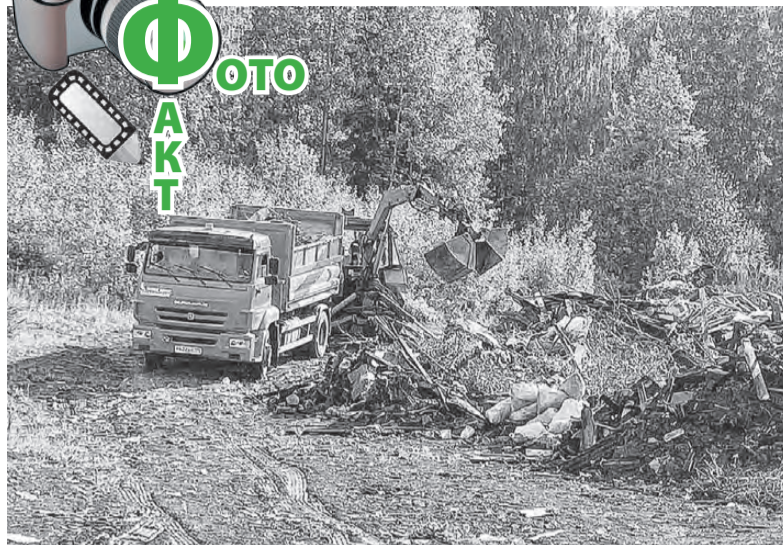
Ликвидация несанкционированной свалки у посёлка Таёжный.
