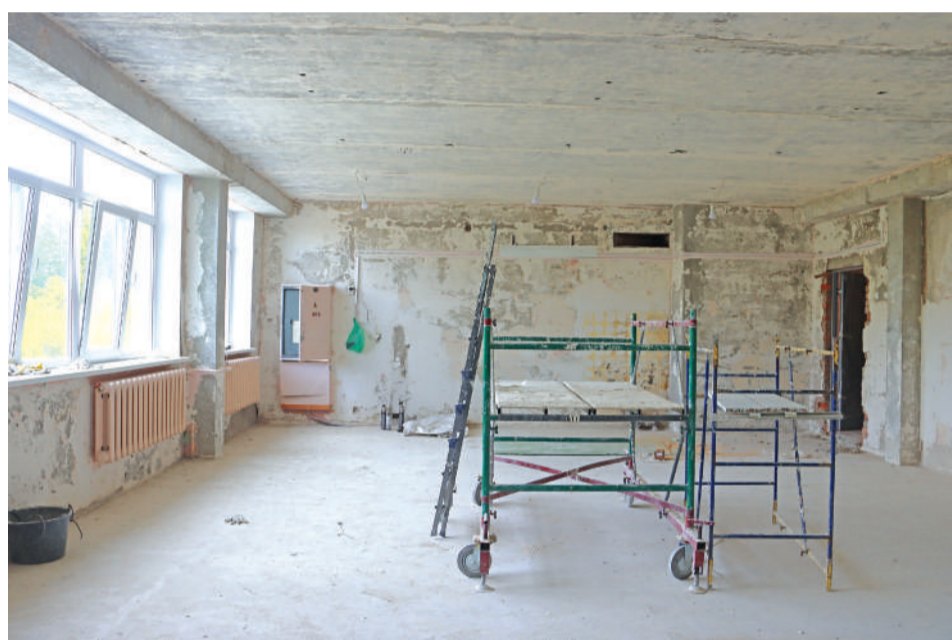
Демонтажные работы в классе информатики 76-й школы.
