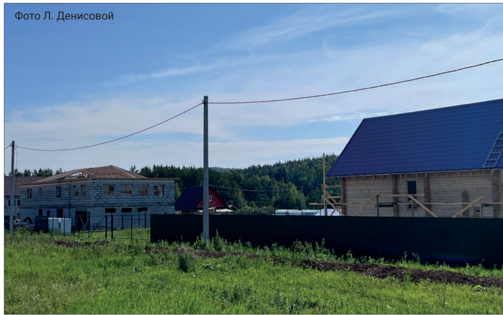
В селе Косой Брод земельные участки, выданные многодетным семьям, активно застраиваются. В планах города – оформить ещё порядка 130 участков для очередников в с. Мраморском и пос. Зюзельском
