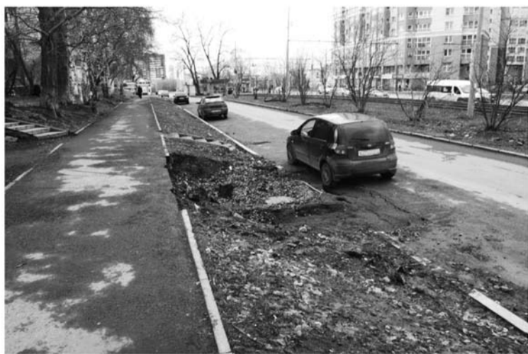
Пример образования грязевого осадка вследствие невыполненной рекультивации
