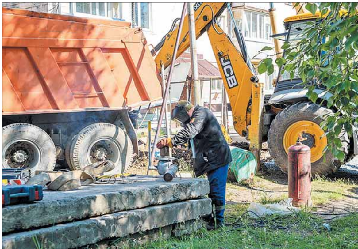
] 27.06.2023 г., поселок Таежный. На улице Центральной идет замена труб подземной укладки полной заменой строительных конструкций / ФОТО СЕРГЕЯ ЧИКИШЕВА
