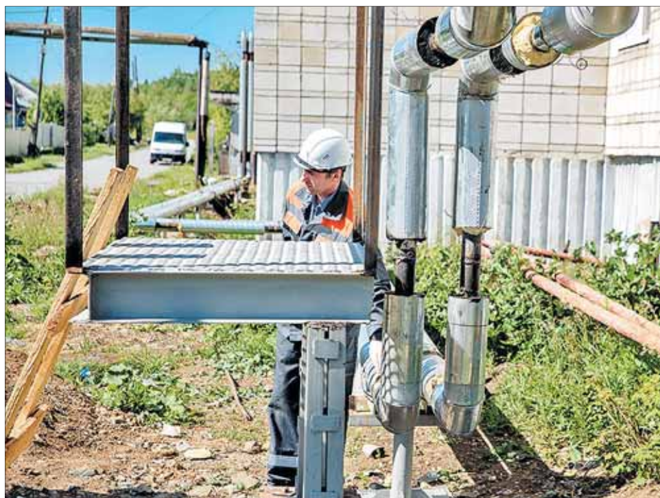
] Игорь Гордюк рассказывает о технологии перекладки надземного участка теплотрассы / ФОТО СЕРГЕЯ ЧИКИШЕВА
