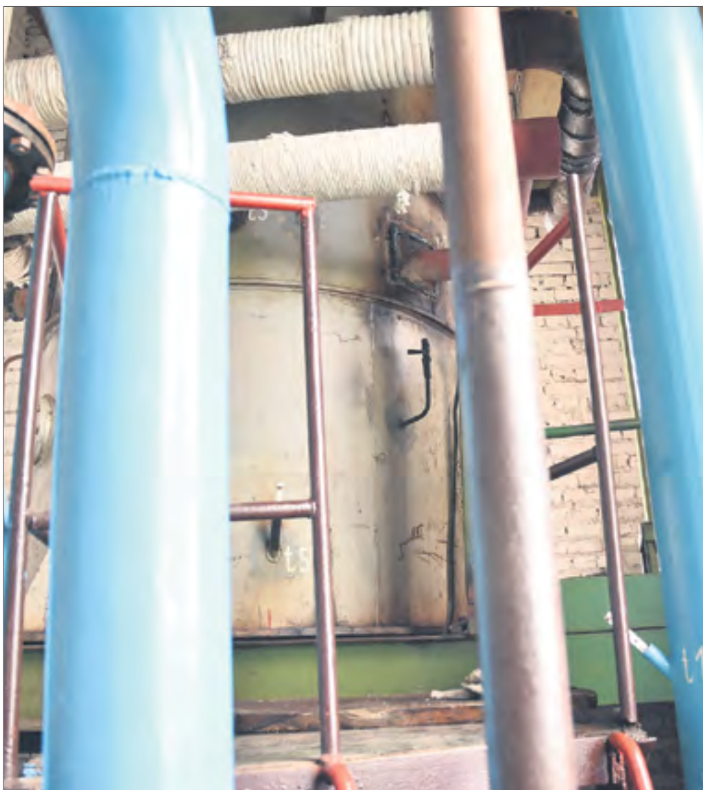
Вот так выглядит деаэрактор. Снаружи — как обычная металлическая бочка. Но без него вообще нельзя подавать воду в систему. // Фото Ольги Вертлюговой
