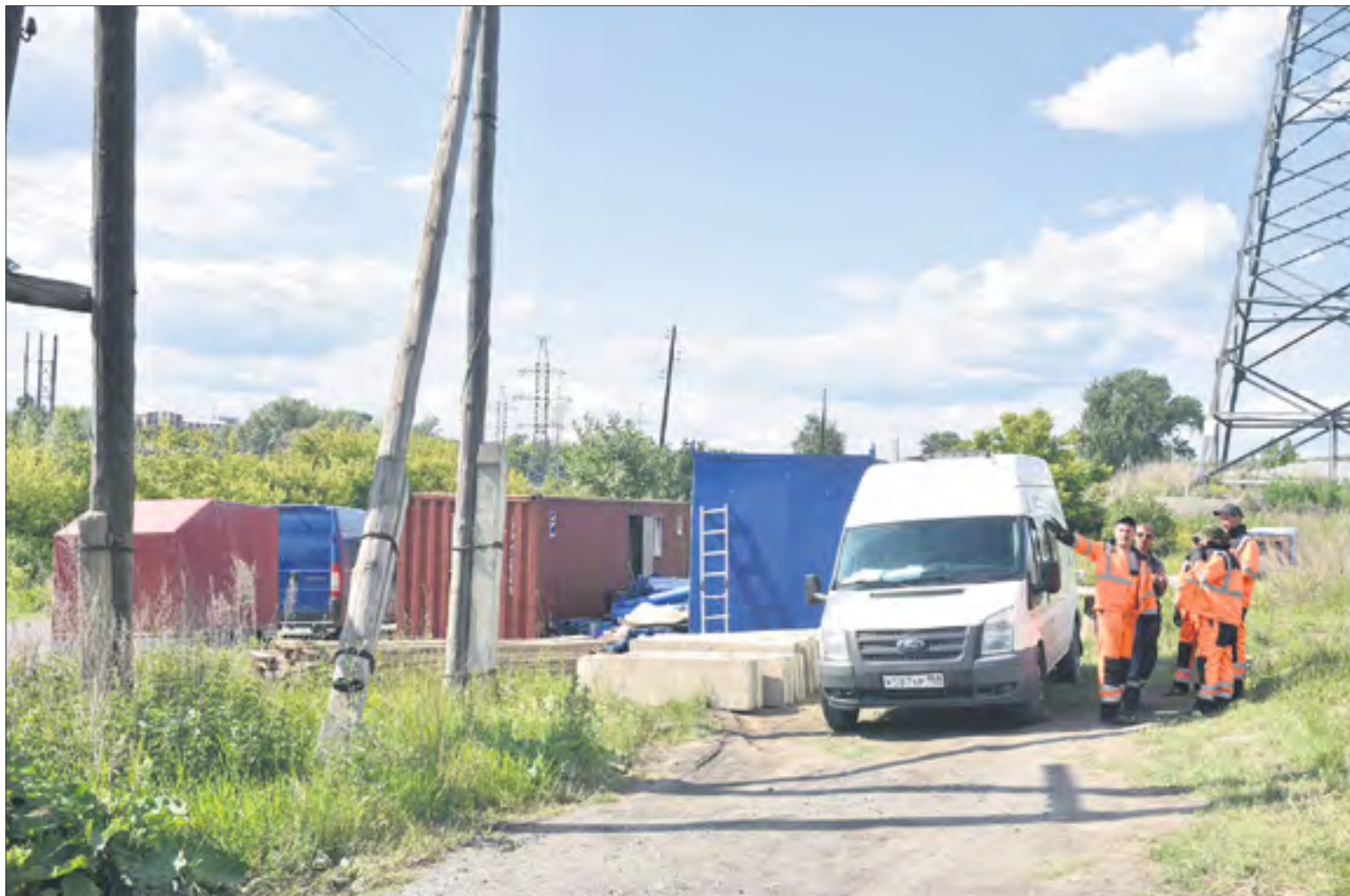
В районе Шараминского моста уже появился строительный городок, техника и сами мостостроители. // Фото Андрея Агафонова
