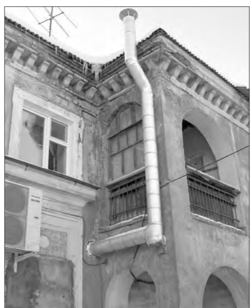
Под окном детской спальни - кондиционер, рядом проходит труба вентиляции.
