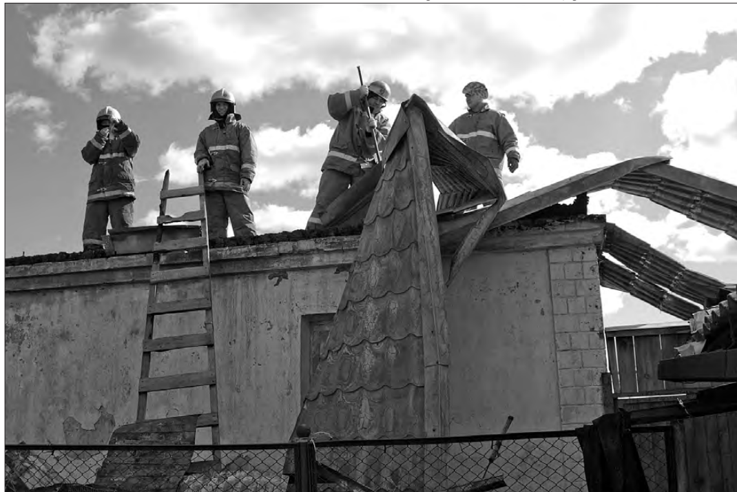
Сотрудники ПЧ №12 разбирают обгоревшую кровлю.
