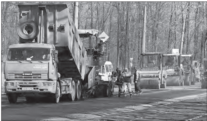
Идет укладка асфальта на улице Metallургов.
