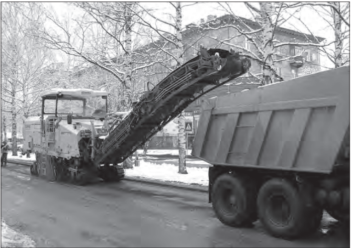
Идет фрезерование дороги на проспекте Мира.
