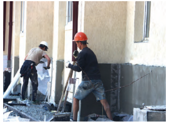
Устройство цоколя дома.
