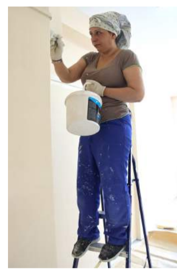
Ремонт помещений детского дневного стационара.
