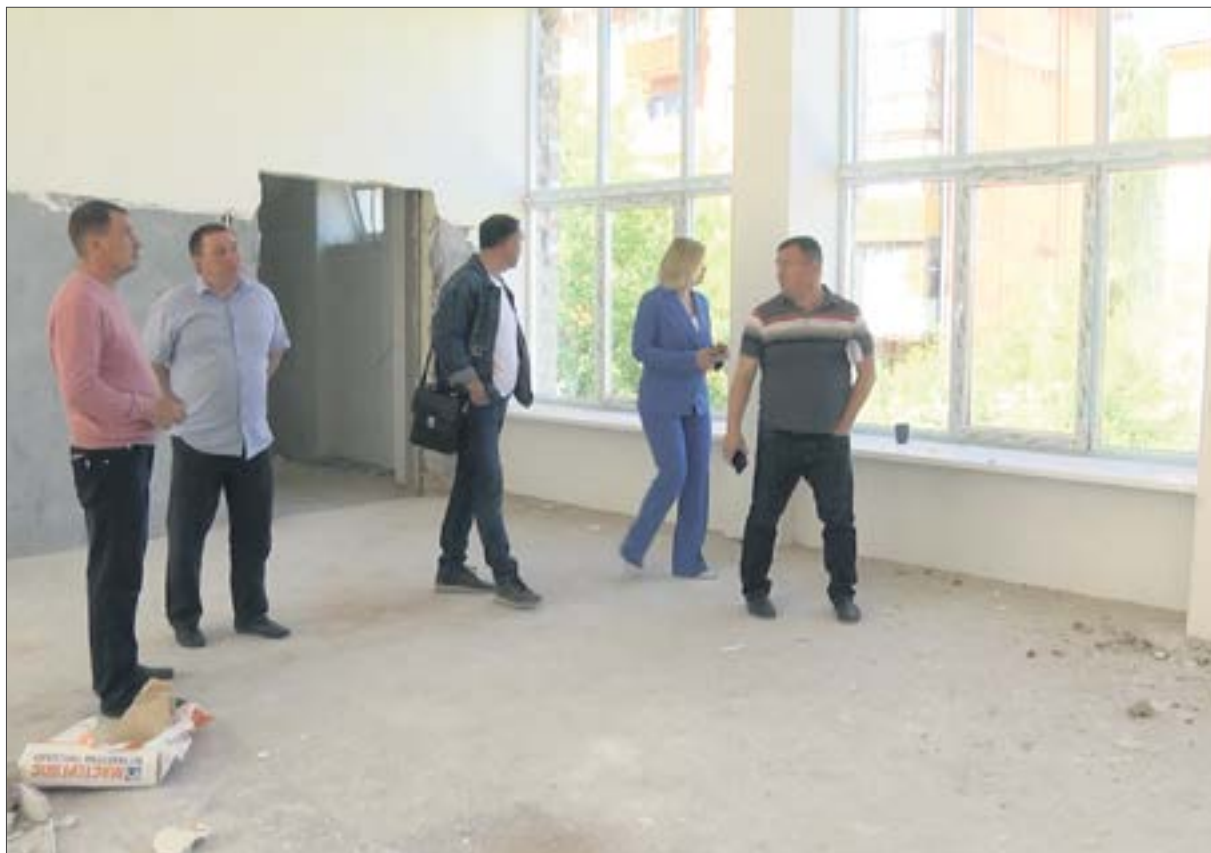
Подготовительные работы, практически, завершены. Скоро строители переходят к чистовой отделке. // Фото Павел Пенкин, ТК «Единство»
