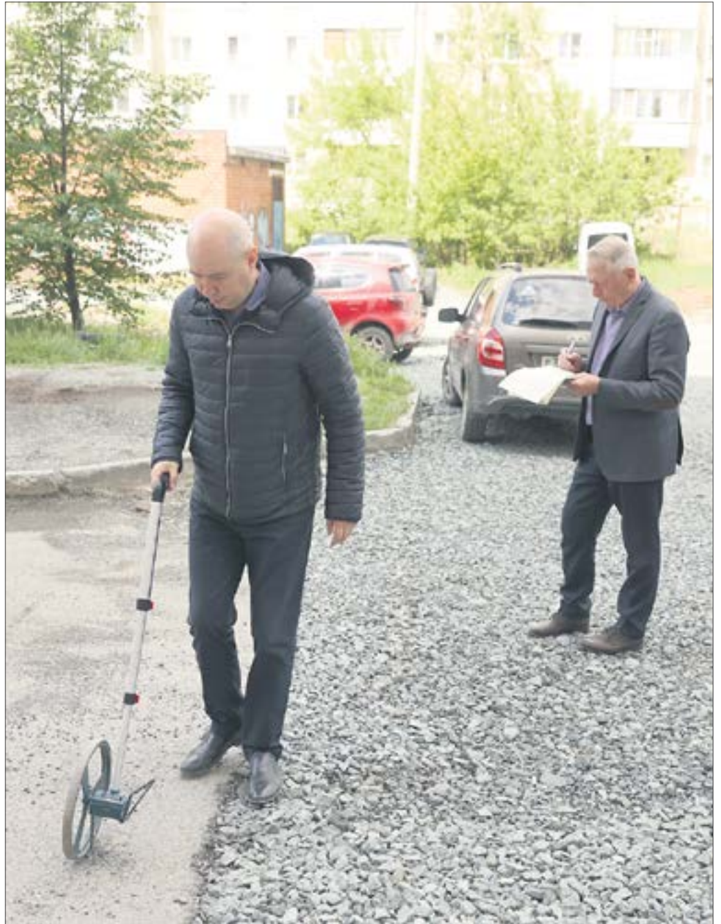
Вот так выглядит процесс со стороны: Александр Закожурников измеряет площадь будущего ремонта курвиметром, замдиректора УГХ Сергей Филиппов фиксирует данные, которые после этого предстоит проанализировать. // Фото Владимира Коцюбы-Белых
