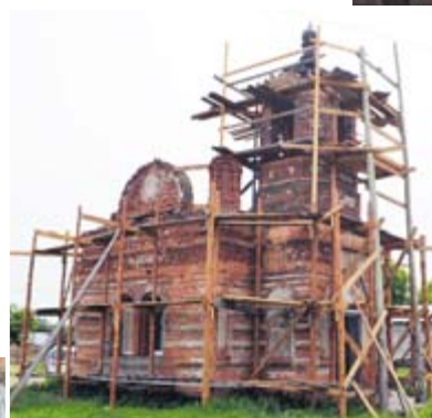
Вокруг часовни установлены леса
